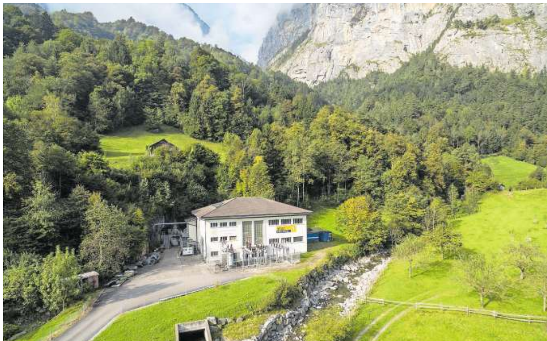
Die Gemeinde Erstfeld bezieht zu 100 Prozent Ökostrom aus eigener Sonnenenergie und Wasserkraft – im Bild die Kraftwerkzentrale Ripshausen. Bild: PD
